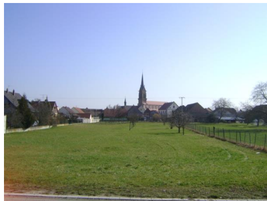
Les points de vue sur l'église depuis le Sud et de l'intérieur du village (RD468)
