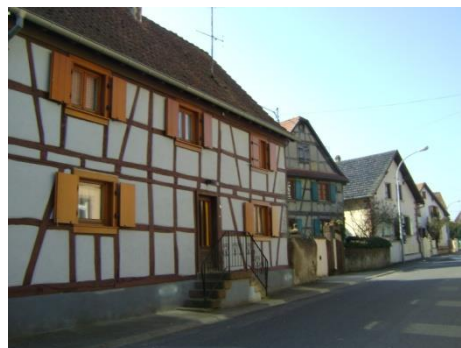
Rue principale R+1+C
