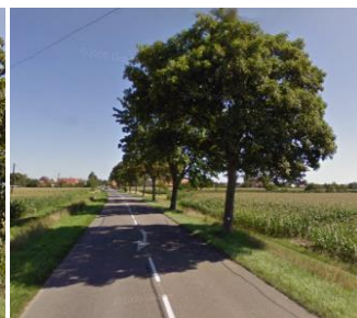
Alignement au Sud (RD468)
